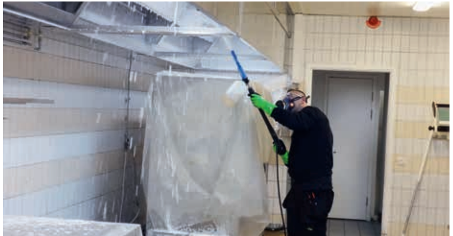
Demonstration der Reinigung von gewerblichen Küchendunstabzugsanlagen (nasses Verfahren).
